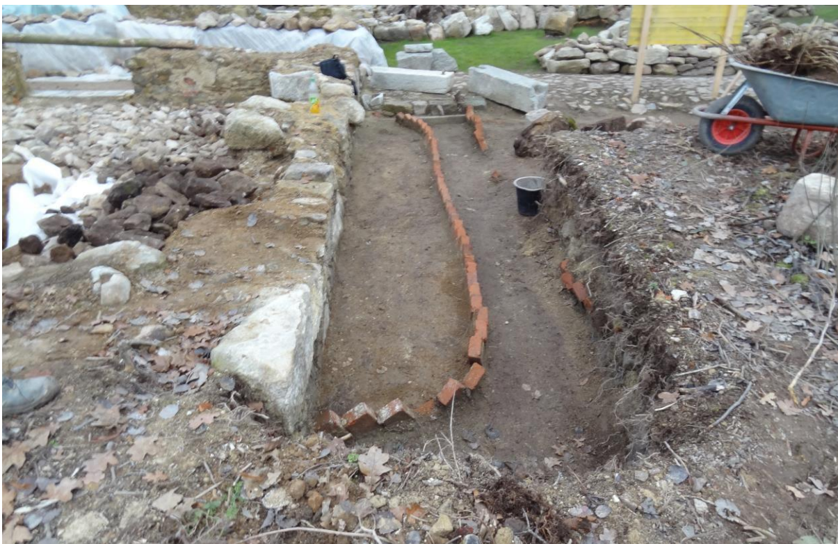
Odkrývání fary v listopadu 2012, prostor záhonu vymezeného obrubníkem z cihel (foto H. Roith)
