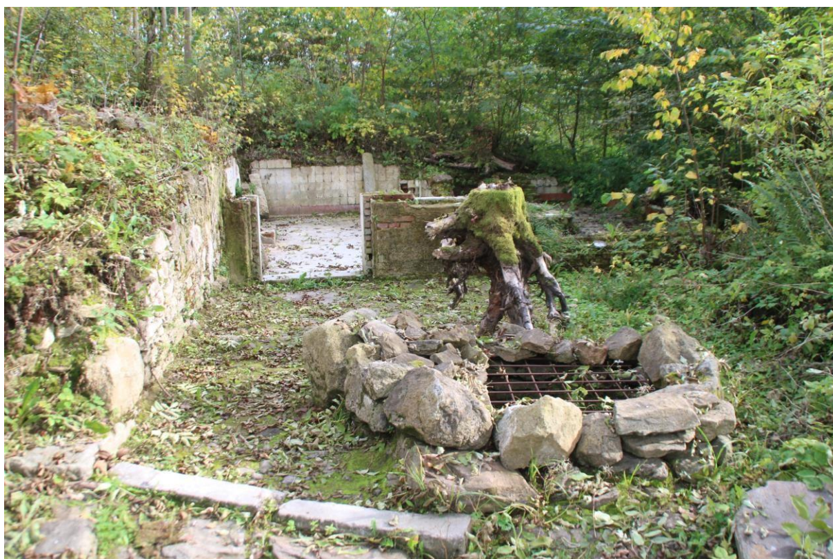
Pohled na vstup do řeznictví, vlevo zdivo domu čp. 5, v popředí studna (foto Z. Procházka 2017)
