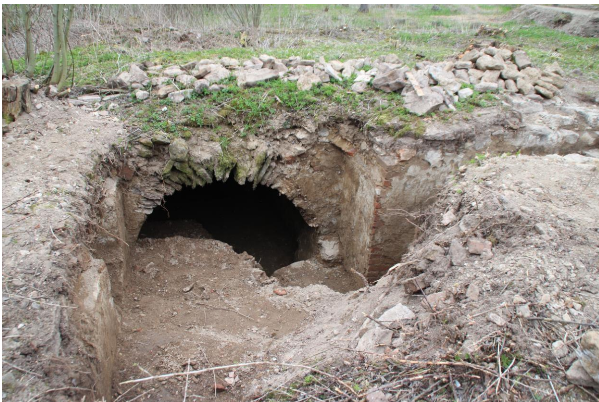
Dům čp. 7 v roce 2016 při vyklízení sklepení (foto Z. Procházka)
