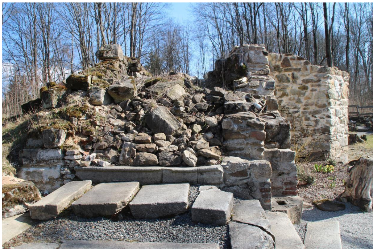
Pohled na zasypaný vstup, který vedl spodní částí věže (foto Z. Procházka 2017)
