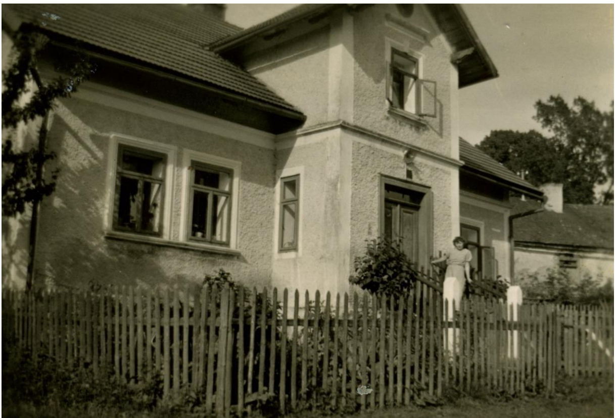
Dům čp. 29, vstup od jihozápadu
