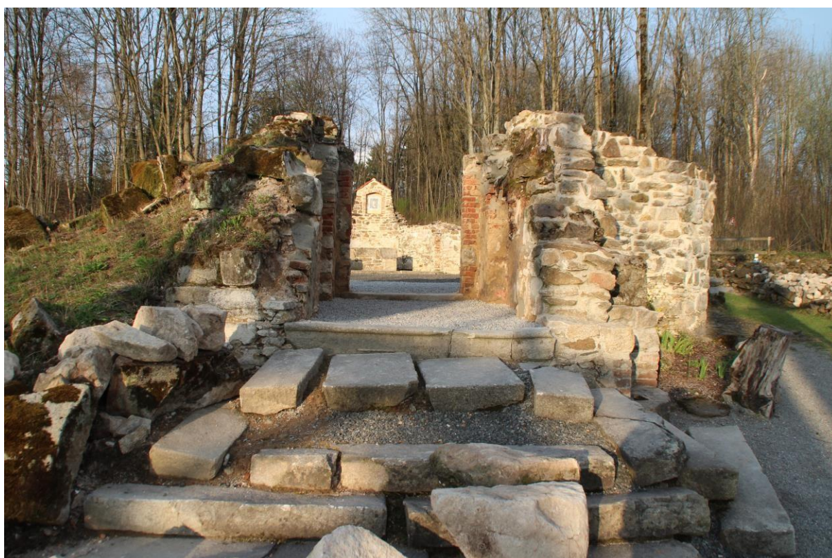
Pohled na odkrytý vstup, který vedl spodní částí věže (foto Z. Procházka 2017)
