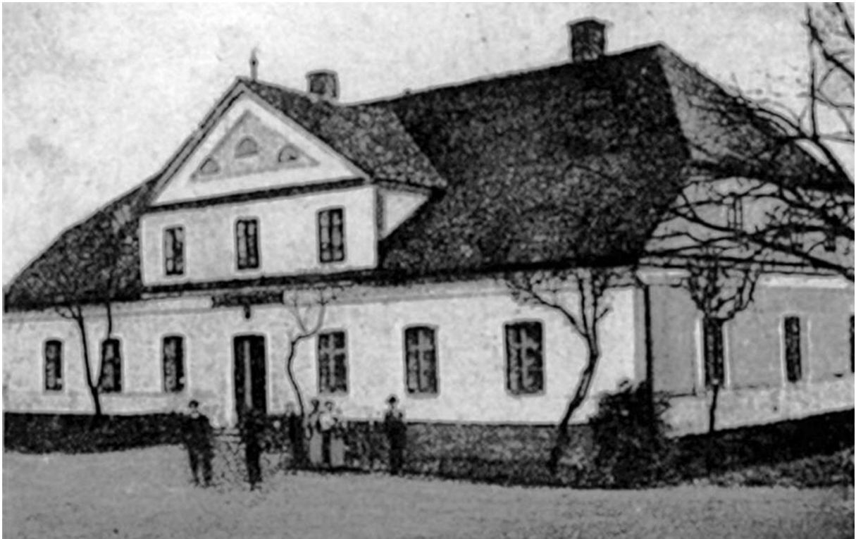
Dům čp. 26, fasáda s hlavním vstupem od severovýchodu (archiv H. Laubmeiera)
