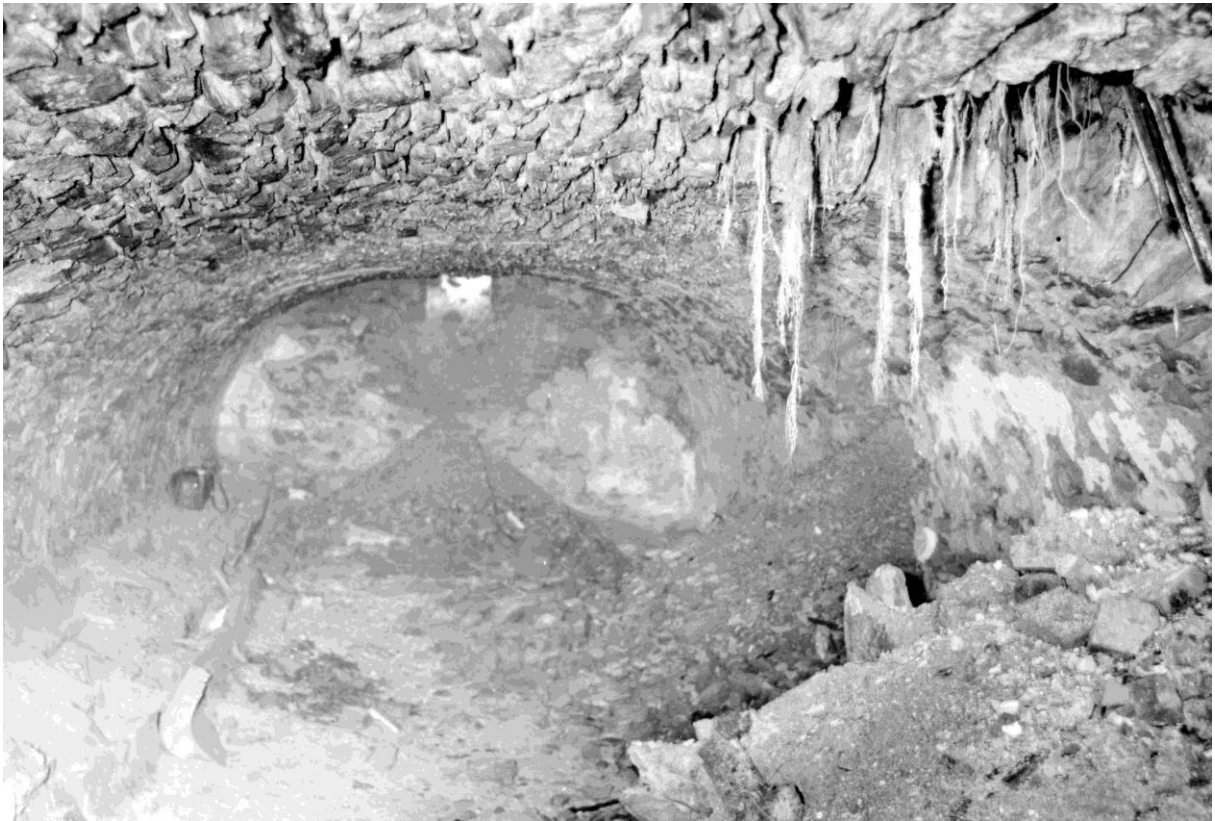
Stáj před zřícením klenby, pohled od vstupu na plánu č. 8 (foto Z. Procházka)
