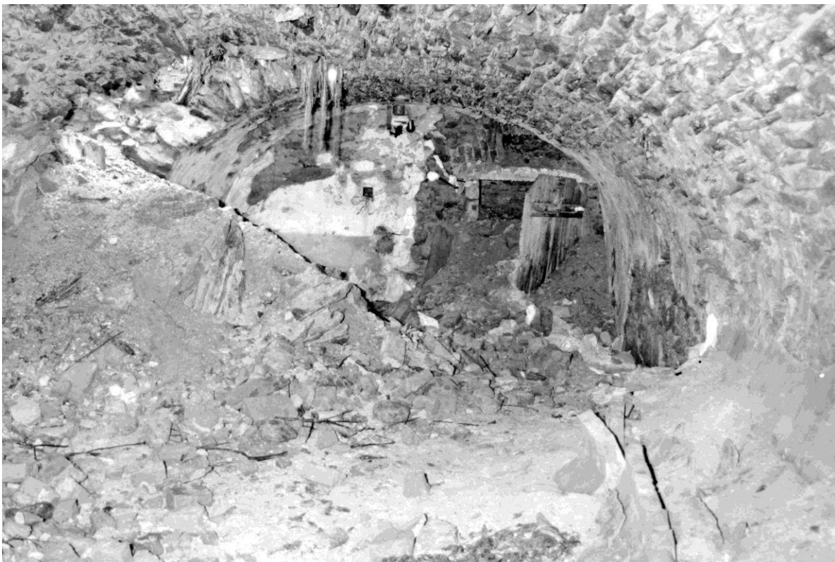
Stáj před zřícením klenby, pohled ke vstupu na plánu č. 8 (foto Z. Procházka)
