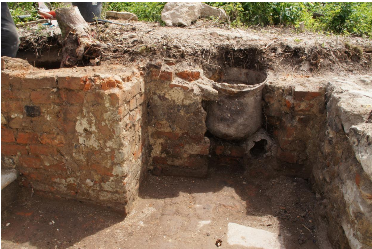
Fara, kotel na ohřev vody v místnosti č. 8 (foto H. Roith)
