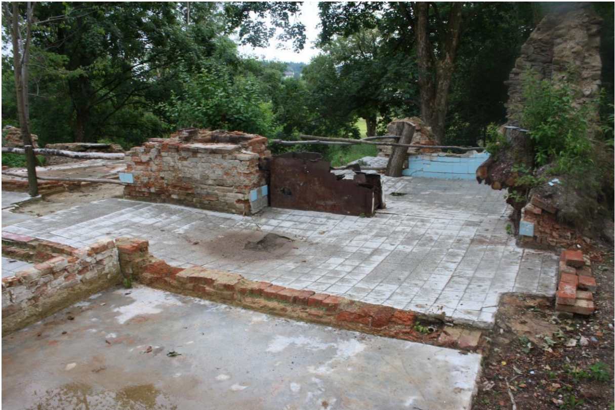
Severozápadní nároží objektu, využívané jako kuchyně útvaru PS (foto Z. P. 2014)
