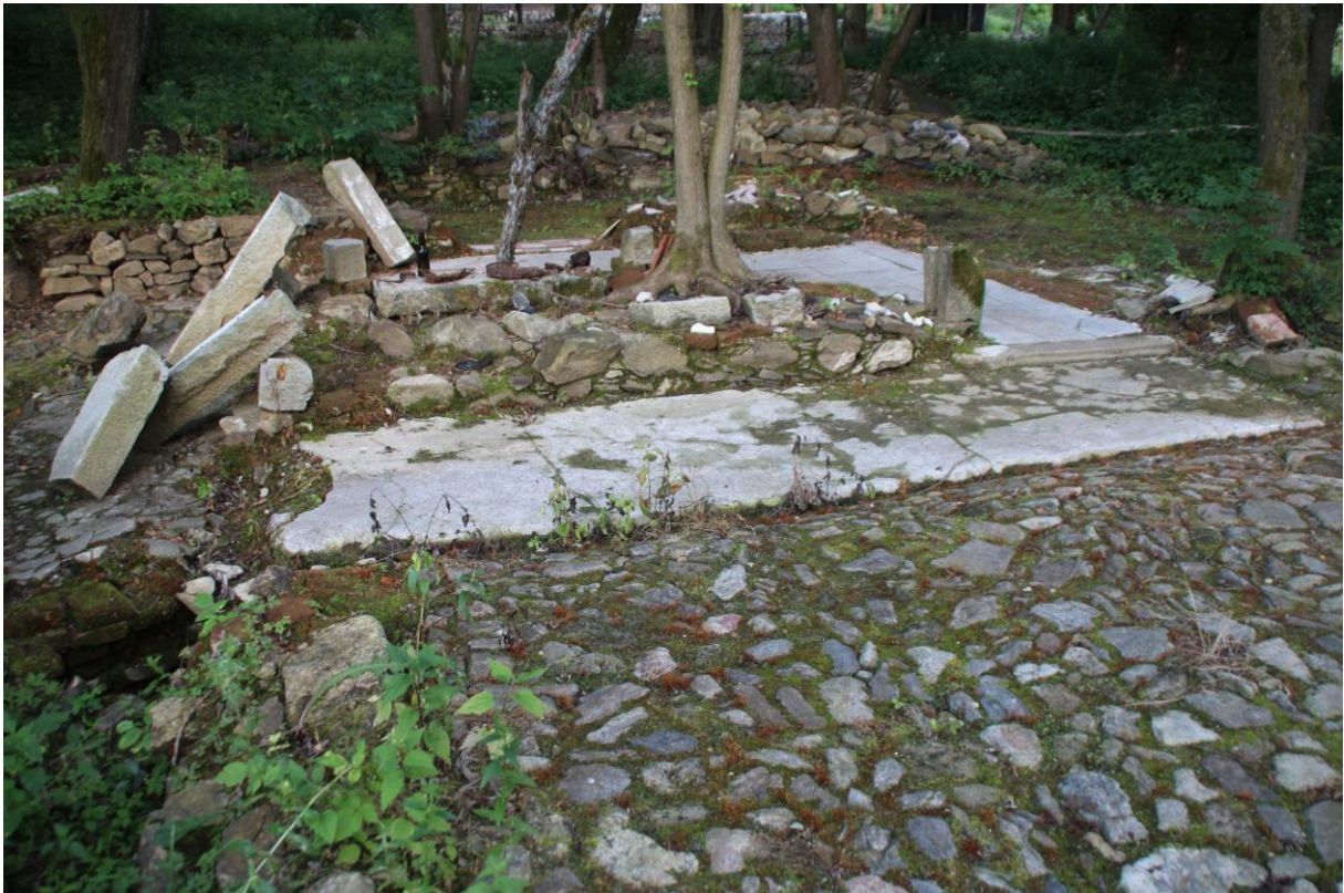
Pozůstatky stavby domu čp. 28, v popředí hospodářská část s chlévy (foto Z. Procházka 2017)
